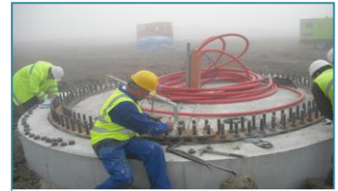
Слика бр. 66. Изведена темељна конструкција
