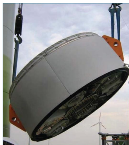
Слика бр. 70. Дизање генератора
